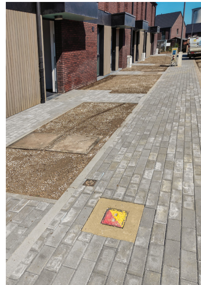
Terrassement d'un lotissement
