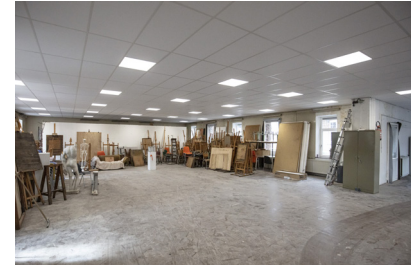
Pose d'un faux plafond par nos stagiaires
