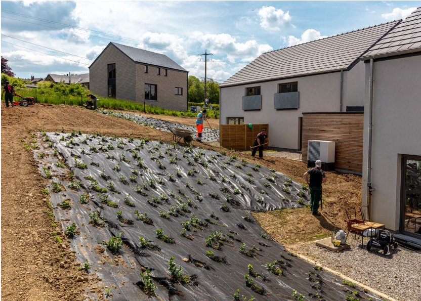
Chantier Parcs et Jardins réalisé par nos stagiaires
