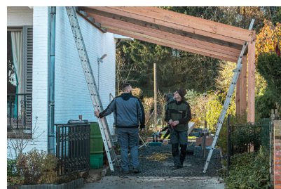
Formation métiers du bâtiment / carport
